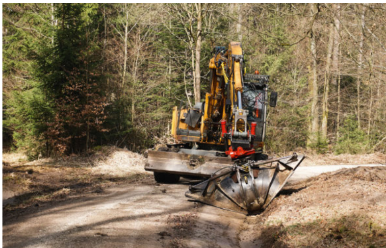
Ein Grabenbagger mit „Rädlinger Trapezlöffel“ sorgt hier für optimal ausgeformte Gräben am Wegesrand.
