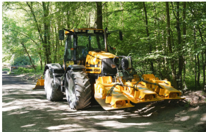
Plattenverdichter im Einsatz: Wenn ein Planierschild das Wegeprofil wieder herrichten musste, ist im Anschluss eine Rückverdichtung nötig.
